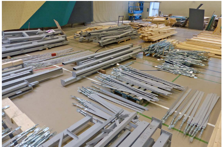
8 Alle diese Bauteile werden noch verbaut.
