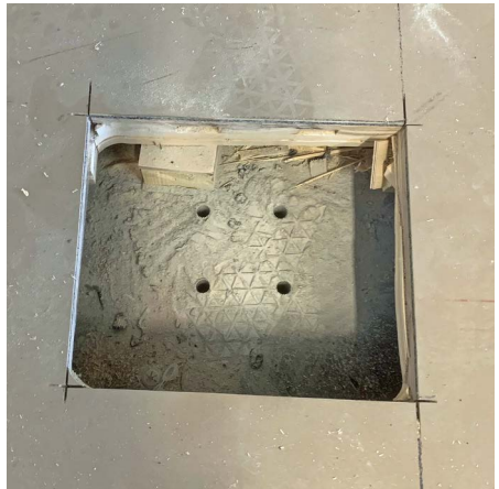
2 Löcher für die Stützenbefestigung im Beton
