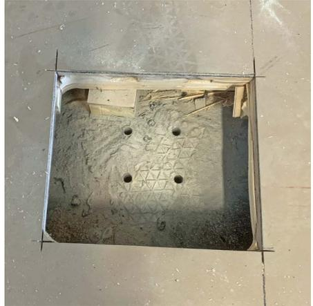
2 Löcher für die Stützenbefestigung im Beton
