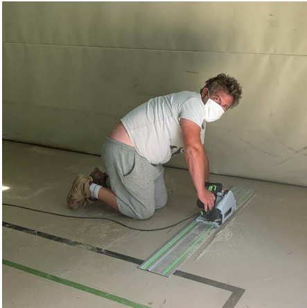
1 Der Hallenboden wird aufgesägt
