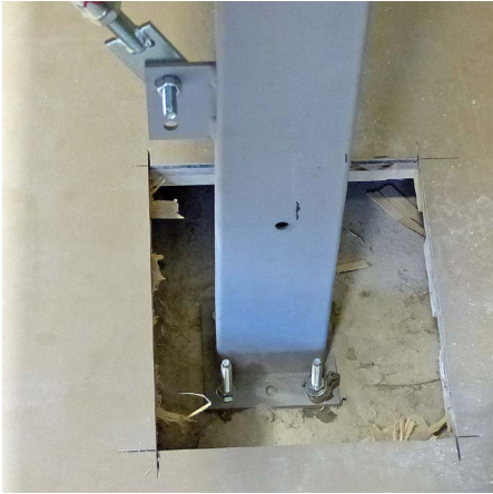
3 Die Stützenbefestigung
