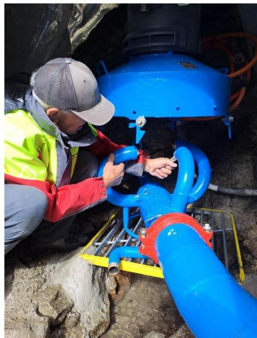
Die Haube, unter der das Turbinenrad eingebaut ist, lässt sich einfach mit einem Bajonettverschluss mit den Düsenrohren verbinden und erlaubt es, Servicearbeiten bequem auszuführen. Dazu muss man die Verriegelungen öffnen und die Haube im Gegenuhrzeigersinn drehen. Anschliessend kann die Haube samt Turbinenrad und Generator mittels Kettenzug angehoben werden, so dass man ungehindert die Düsen reinigen oder auswechseln kann.
