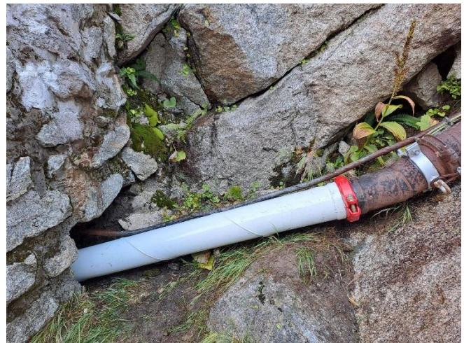
Nachdem wir die revidierten und neu erstellten Rohrstücke und Krümmer zusammengebaut und mit der alten Rohrleitung verbunden hatten, füllten wir das Staubecken und spülten die Druckleitung.
