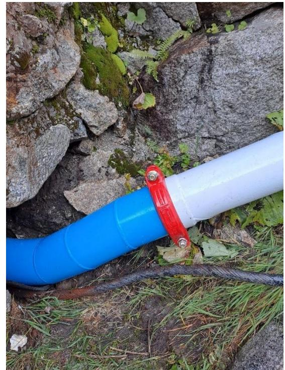
Als nächstes testeten wir das ganze System. Es ging darum, die Dichtheit der Druckleitung und des neu angeschlossenen Druckrohrabzweigers sowie die korrekte Anströmung der Turbine zu überprüfen. Zu unserer grossen Freude ist dieser Test zur vollen Zufriedenheit ausgefallen. Dieser Erfolg ist der perfekten Planung und Organisation unseres Hüttenchefs Willi, der guten Arbeit unserer Lieferanten und dem beherzten Einsatz der oben erwähnten SAC Mitglieder zu verdanken. Dank
