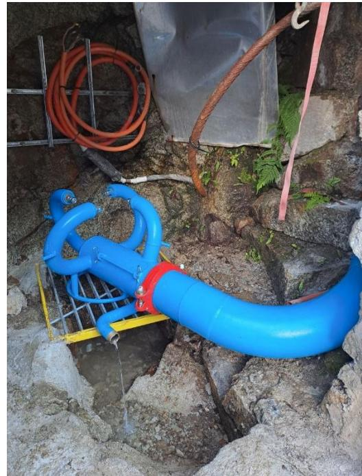
Dazu musste die Kranschiene montiert werden, mit der die ca. 120 kg schwere Turbinengruppe in die Kaverne eingefahren und auf den Druckrohrabzweiger mit den Düsenrohren aufgesetzt wurde.
