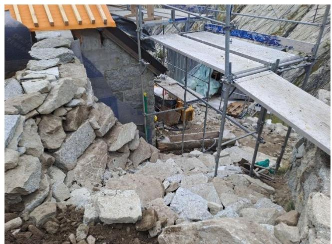
Als nächstes halfen wir den Bauleuten von Maurer+Raz AG beim Hinterfüllen der Nordseite der Hütte und beim Einbetten der diversen Leitungen, die in den Technikraum geführt werden.
