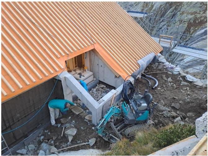
Im Auftrag unseres Architekten machten wir uns am späteren Mittwochnachmittag daran, den Hinterausgang der Hütte zu gestalten. Unterhalb der zweiten Betonkonsole musste eine Natursteinmauer aufgebaut werden und vom Hinterausgang auf das aufgeschüttete Terrain verlegten wir eine Treppe mit Natursteinen.
