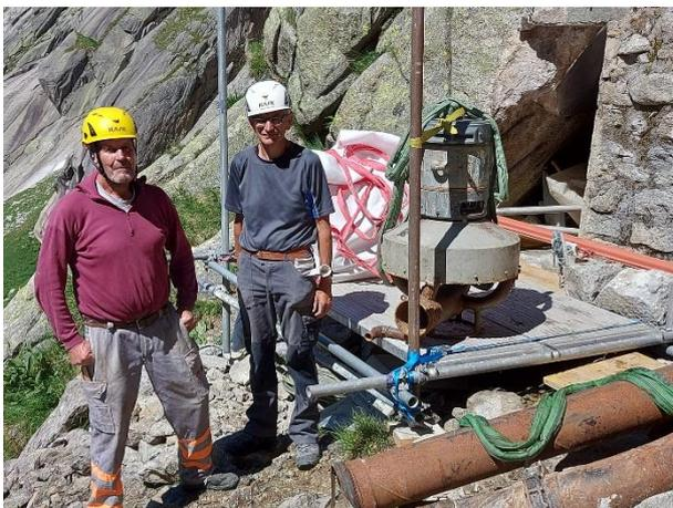
Dank der guten Arbeitsvorbereitung war die Stromerzeugungsgruppe nach gut einem Tag Arbeit ausgebaut und bereit für den Transport ins Tal. Spezialisierte Firmen werden die nächsten Wochen den Generator und das Einlaufgehäuse mit Düsenträger fachgerecht revidieren.
