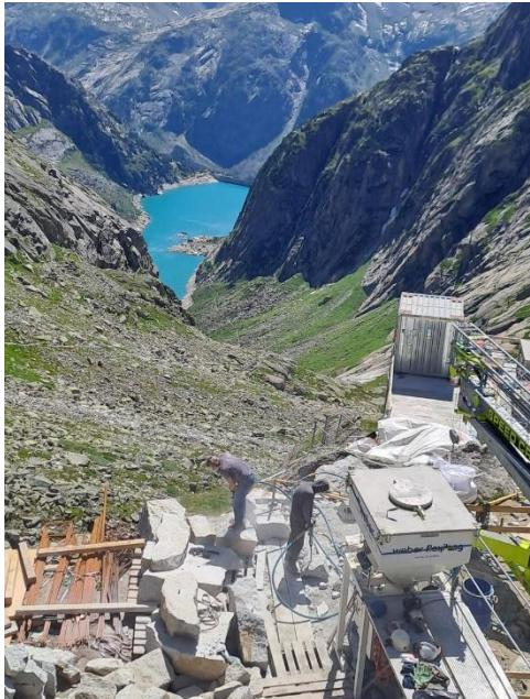
Chrigel, der Polier, hat uns für diesen Einsatz zwei Pressluftanschlüsse zur Verfügung gestellt, so dass wir zwei Bohrhämmer parallel betreiben konnten. Entsprechend schnell kamen wir mit dem Löcherbohren und dem Zerteilen der Felsbrocken voran.
